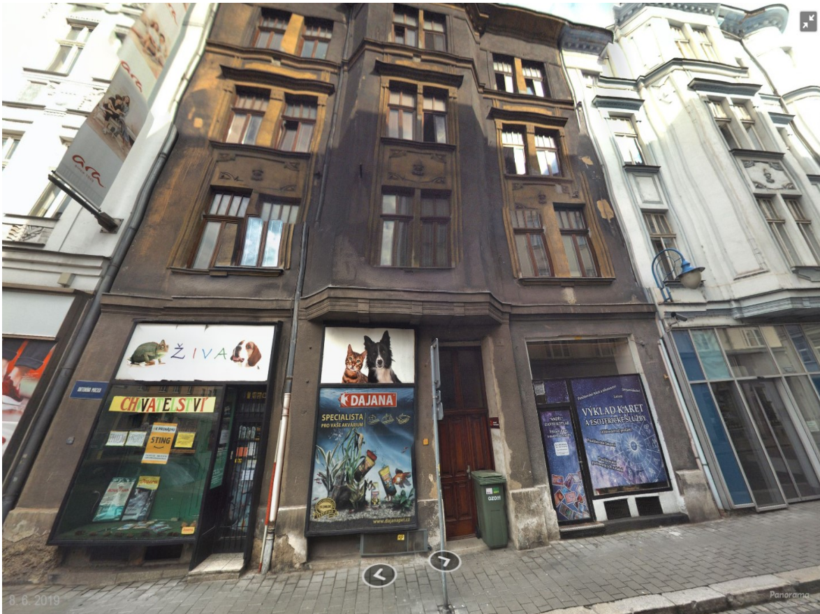
Budova – bytový dům č. p. 1711 ve vlastnictví Ivety Škubalové na pozemku parc. č. 508/1, k. ú. Moravská Ostrava
