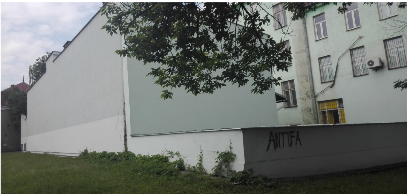
Pohled zezadu na dům žadatele a vedlejší pozemek parc. č. 3725 a parc. č. 3719/2, jehož součástí je budova (spisovna odboru vnitřních věcí SMO) ve vlastnictví statutárního města Ostravy
