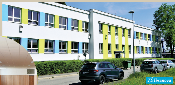
ZŠ Ibsenova má opravenou tělocvičnu
