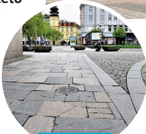
Dlažba je mnohde popraskaná
