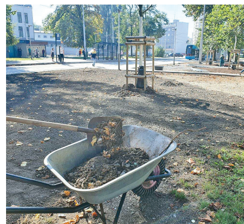
Práce v sadu Boženy Němcové začaly v roce 2021 a budou pokračovat ještě několik let.
