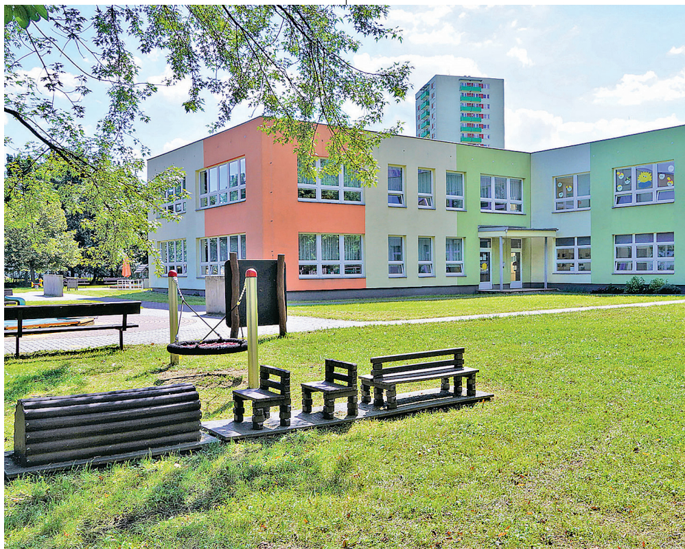
Rekonstrukcí prošla v loňském roce také MŠ Lechowiczova.
