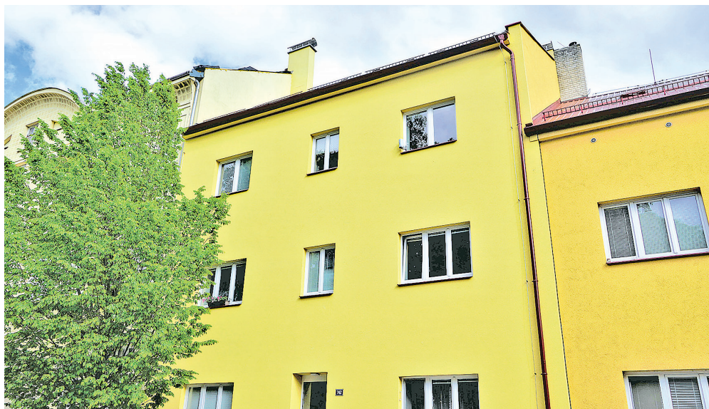
Bytový dům Fügnerova 6 byl kompletně rekonstruován.
