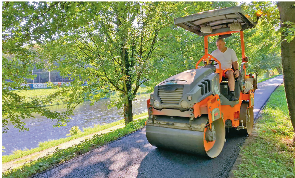
Rekonstrukce se dočkala i oblíbená cyklostezka v Komenského sadech. Foto: Ostravské komunikace.
