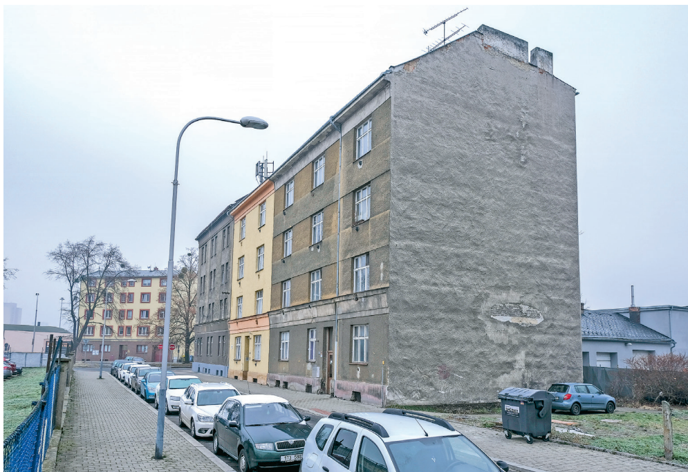
Jednou z velkých rekonstrukcí letošního roku bude i oprava bytového domu v ulici Tolstého 12.
