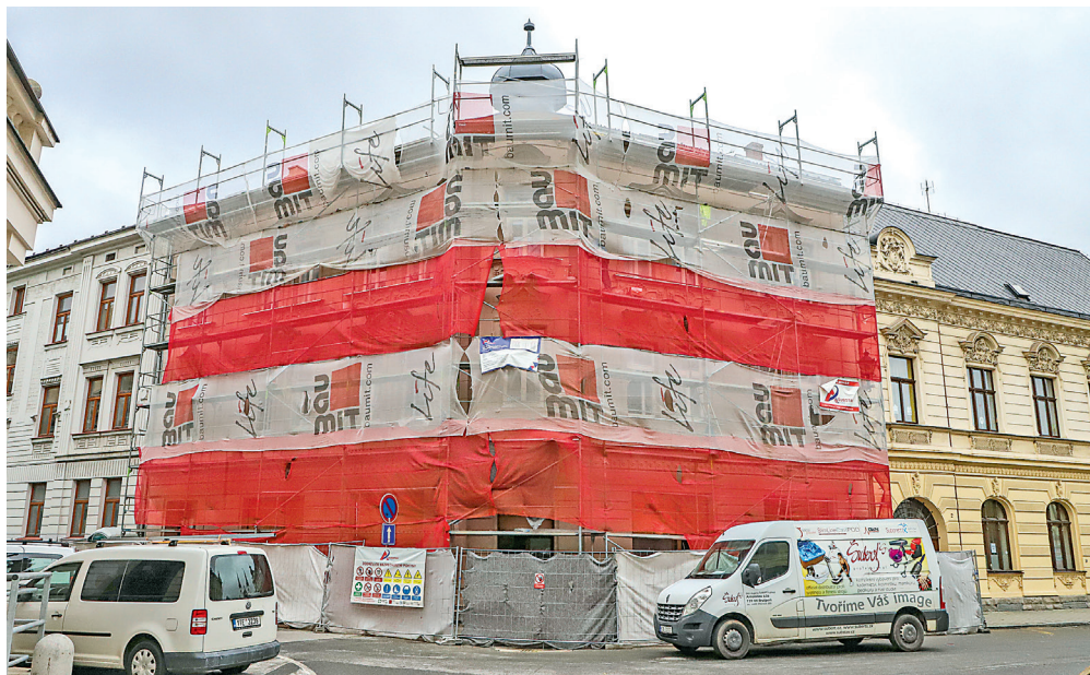
Bytový dům U Tiskárny 2 prochází rozsáhlou rekonstrukcí.
