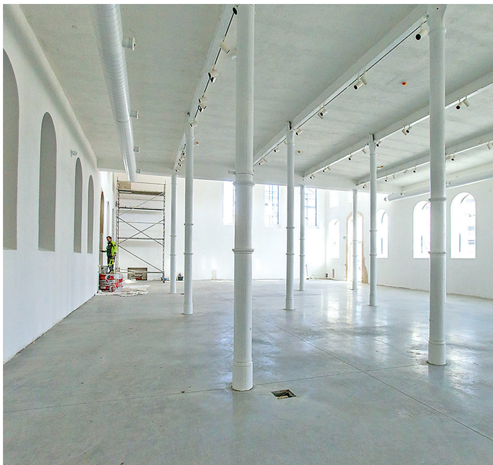
Interiéry galerie před dokončením posledních úprav.
