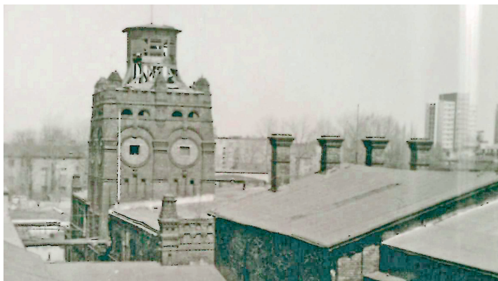
Vpředu vpravo předchladírna se schodištěm do patra a stříškou, spojující předchladírnu s dnes již neexistující budovou hovězí porážky (vlevo), v pozadí budova chladírny s věží, 1984, (foto Karel Fon, NPÚ-ÚOP v Ostravě, fotoarchiv, A 70 162)
