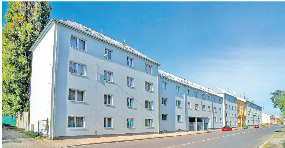
První opravený dům u Cihelní ulice.
