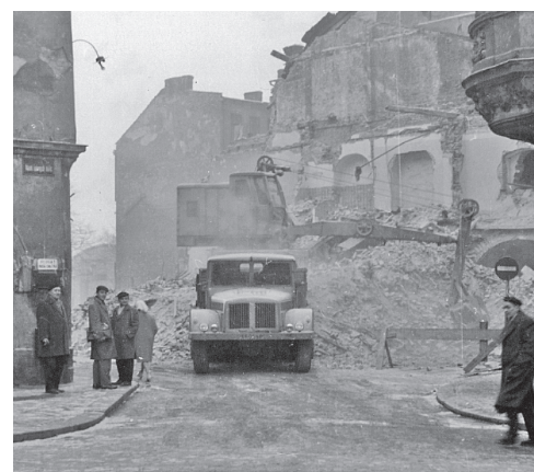
Demolice domu Velká 1 zvaného Pírek, 1964. Zcela vlevo nároží staré radnice.
