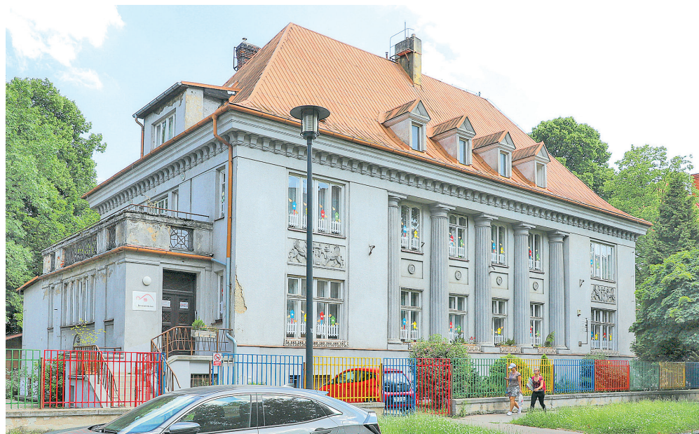
Budova před rekonstrukcí
