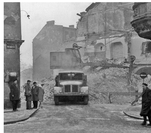
Demolice domu Velká 1 zvaného Pírek, 1964. Zcela vlevo nároží staré radnice.
