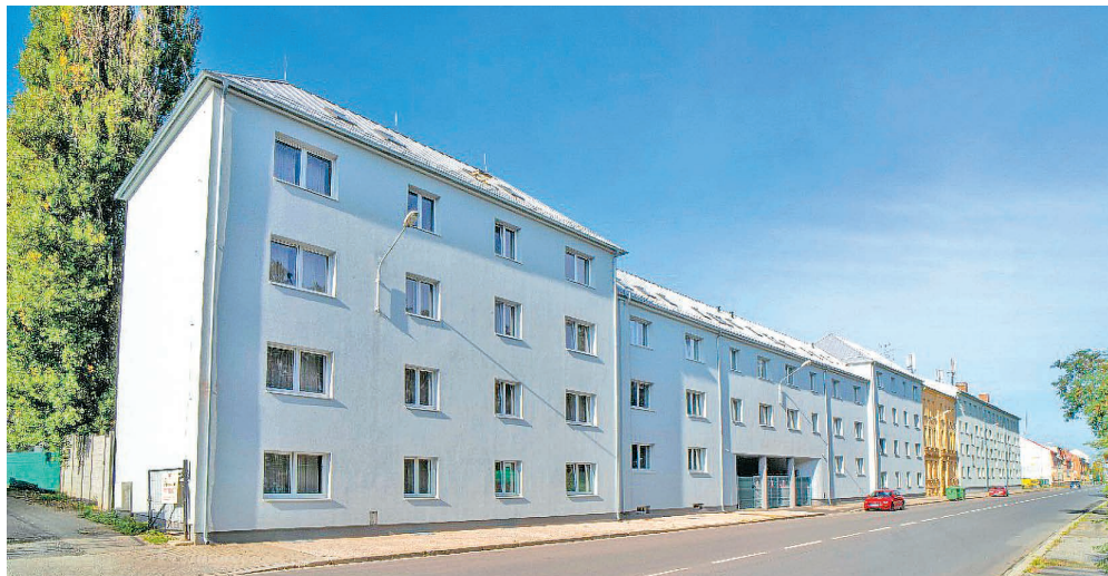
První opravený dům u Cihelní ulice.
