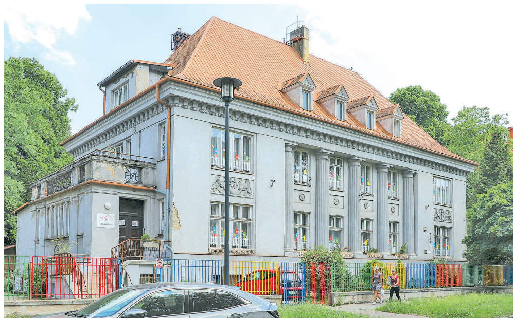
Budova před rekonstrukcí
