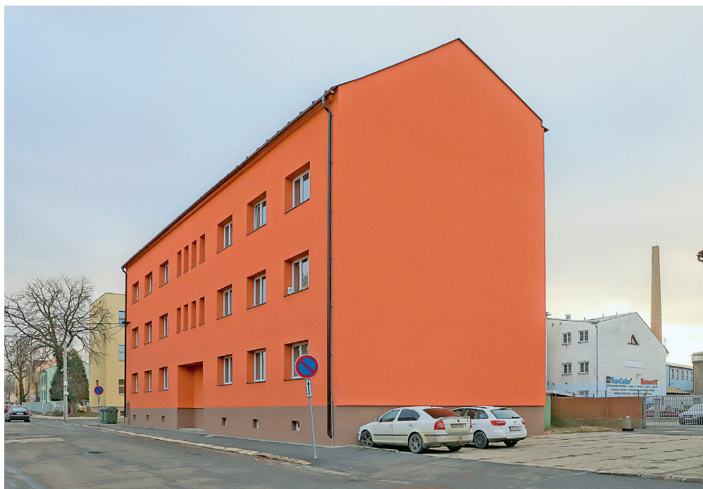
Bytový dům v ulici Úprkova 10 v Přívoze prošel celkovou rekonstrukcí.
