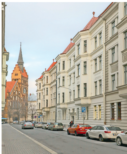
Bytový dům v ulici Chelčického 10, který byl loni zrekonstruován, se nachází v památkové zóně.
