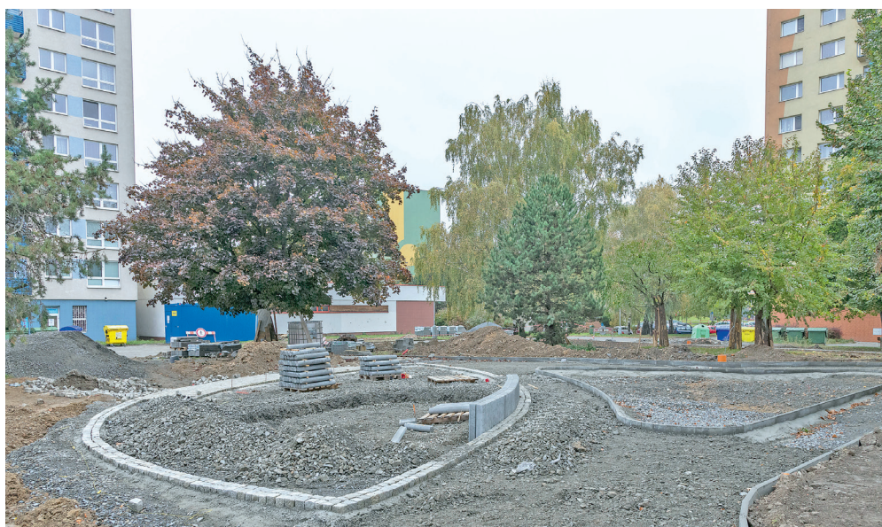
Práce na další etapě regenerace sídliště Fifejdy II jsou v plném proudu.
