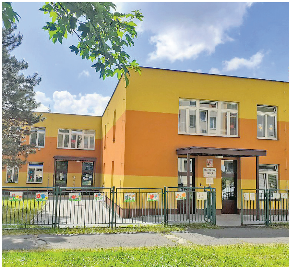
Budova MŠ Repinovy prošla před šesti lety celkovou rekonstrukcí.
