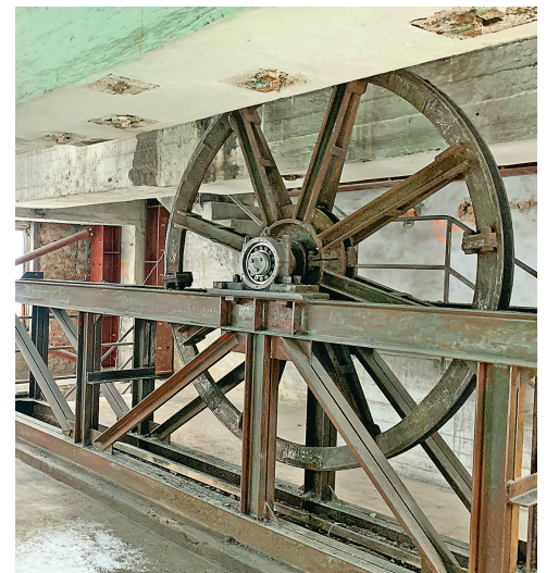
Oběžné kolo, které kdysi zajišťovalo odvětrávání dolu, zůstane součástí nových interiérů.
