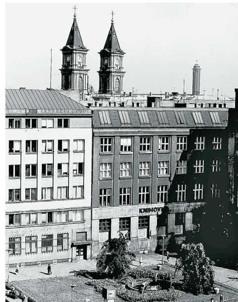
Bývalá budova knihovny na nám. Dr. E. Beneše.
