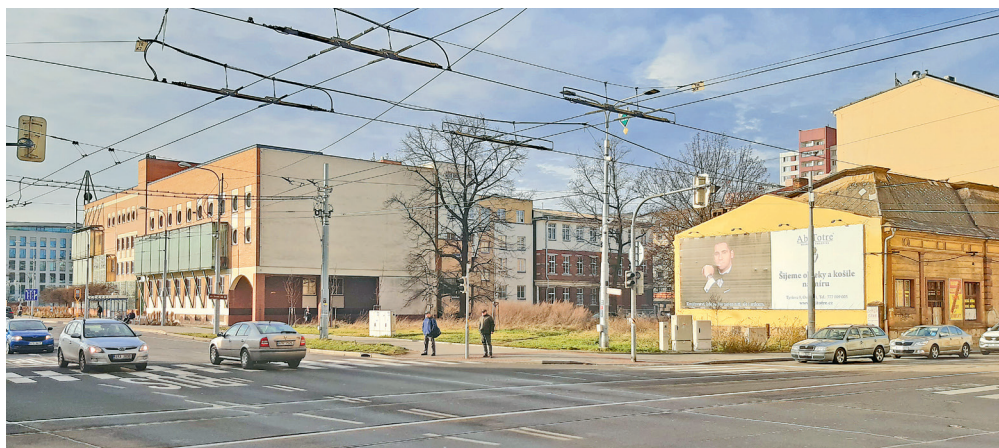
Současný stav lokality, v níž bude postavena nová Křižovatka.
