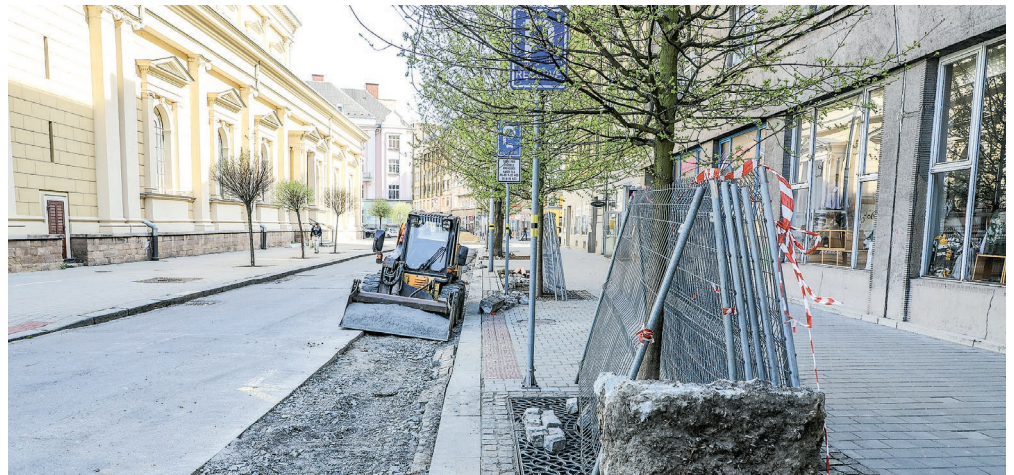
Opravy vodovodních řadů a kanalizace budou v okolí katedrály Božského Spasitele probíhat minimálně do podzimu letošního roku.
