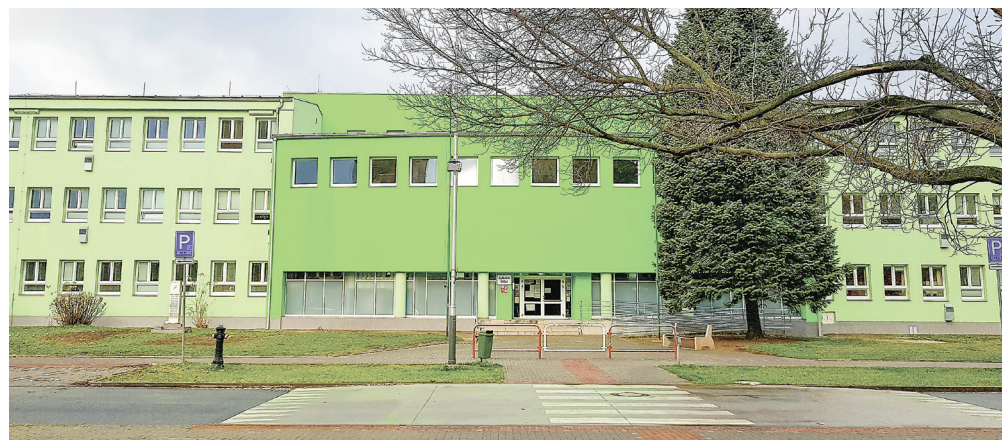
Základní škola Zelená prošla velkou rekonstrukcí.
