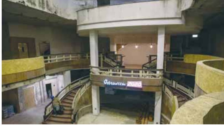
Uvnitř bývalého módního domu Ostravica-Textilia probíhají stavební práce.
