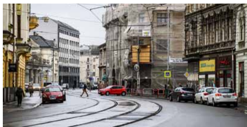
Rekonstrukce ulice Nádražní pokračuje.
