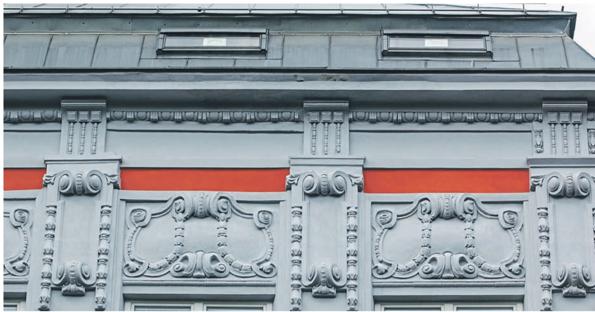
Loni byla provedena výměna oken a oprava fasády Základní školy Matiční 5.
