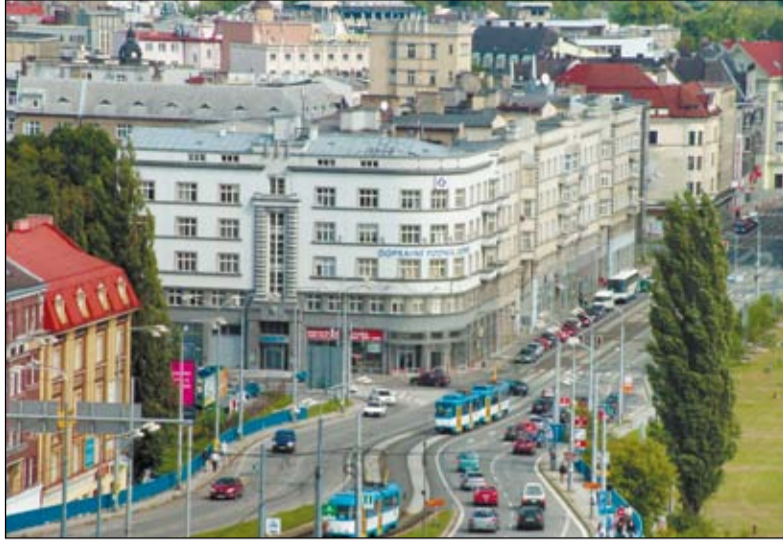
Nesselrothovy pasážové domy - v současnosti je v nich mj. i sídlo Dopravního podniku města Ostravy - byly postaveny na místě po zbouraném tramvajovém nádraží.
