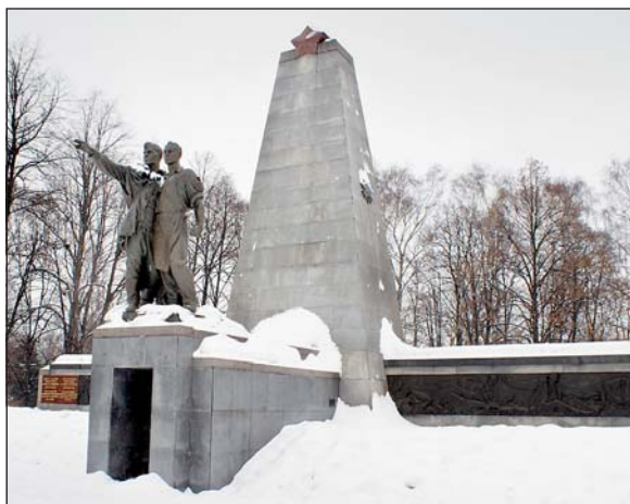
Okolí pomníku Rudé armády v Komenského sadech projde do 30. dubna komplexní rekonstrukcí.
