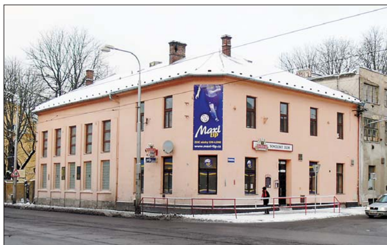
Sokolský dům v Přívoze. Přístavbu – obytný a administrativní objekt – v pravé části snímku čeká generální rekonstrukce.
