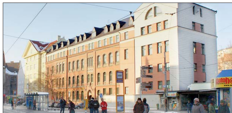
Současný stav rekonstruované budovy někdejšího ředitelství Vítkovických kamenouhelných dolů.
