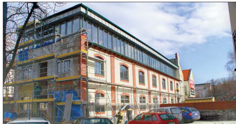
Přístavba těsně před dokončením: odstraňuje se lešení.
