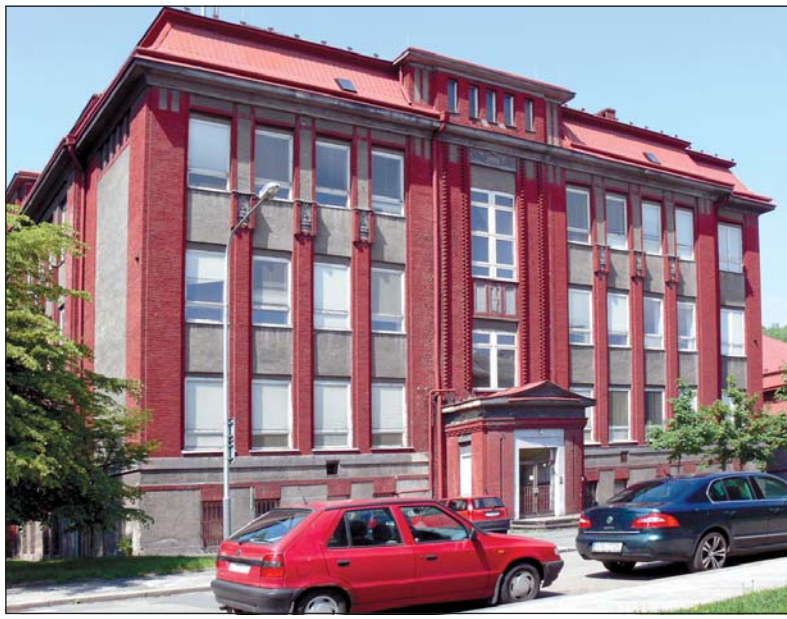
Několik budov a zařízení ZŠ Gebauerova sjednocuje jednotná barevná fasáda.
