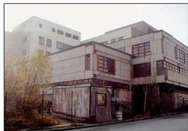
Objekt META před zahájením stavby Integrovaného bezpečnostního centra.
