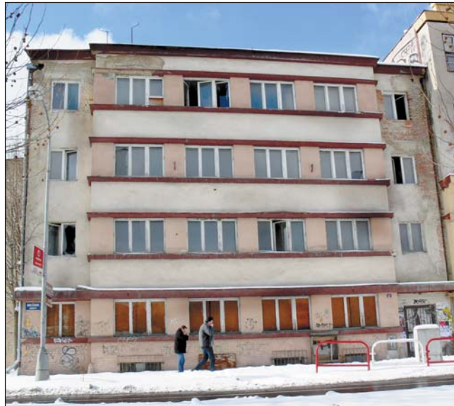
Dům na Havlíčkově nábřeží čp. 27 je neobydlený a připravený k rekonstrukci. Na snímku vpravo je studie fasády budoucího Casa sul Fiume.
