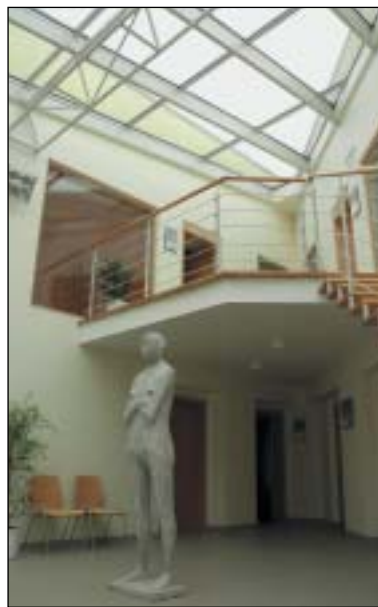
Rekonstruovaná budova na ul. Mlýnská 5 má prosklenou střešinu.
