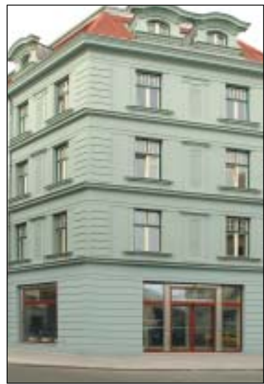
Architektonicky je tato stavba řešena ve tvaru písmene „V“, které je vymezeno ulicemi Mlýnská a S. K. Neumannova.
