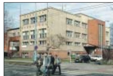
Čapkovy sokolovny v Ostravě je funkcionalistická stavba, kterou v roce 1932 projektoval vynikající brněnský architekt Miroslav Kopřiva.
