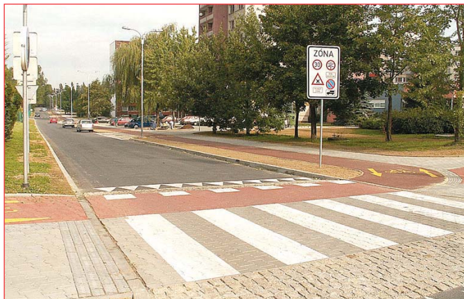
Regenerace sídliště Varenská (foto 5) za 6 732 095 Kč: šlo o rekonstrukci ul. Sládkovy od křižovatky s ul. Varenskou po ul. U Stadionu. Byl položen nový povrch na vozovku a chodníky, zbudováno parkoviště (41 stání), cyklistická stezka. Také byla vysazena zeleň.
