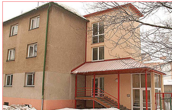
Dům s pečovatelskou službou, Dobrovského 53 – přístavba pro výtah (foto 6) za 2 147 130 Kč. V přístavěném objektu je umístěn osobní výtah jezdící ze sklepa až do II. patra. Vstup je zajištěn přímo z ulice a ze zahrady a také přes kryté venkovní schodiště.
