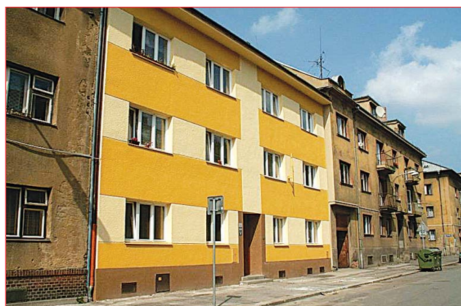
Rekonstrukce domu Jílová 26 (foto 12) za 1 594 189 Kč: bylo provedeno zateplení a obnovu dvorní fasády, opravena byla uliční fasáda, výměněna okna, střešní krytina a vstupní dveře. Byly také opraveny komíny, hromosvod i zpevněné plochy ve dvoře.
