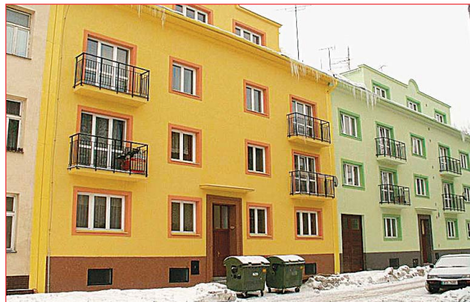
Rekonstrukce domů Vaškova 21, 23 (foto 4) za 5 321 432 Kč: došlo k obnově fasád, výměně oken, vstupních dveří i vrat průjezdu, zateplení sklepů a průjezdu, kde je nová zámková dlažba. Opraveny byly balkony a sklepní boxy. Dům č. 21 má novou střešní krytinu.
