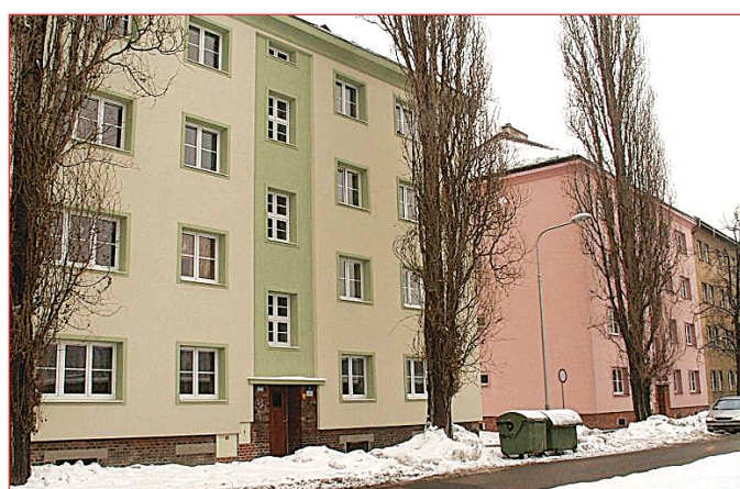
Rekonstrukce domu Valchařská 6 (foto 10) za 2 732 310 Kč: zahrnovala zabudování plastových oken, zateplení obvodových stěn vč. obnovu fasádní omítky, rozšíření etážového topení, obnovu sklepních prostor včetně lafování boxů. Dům má nové vstupní dveře.
