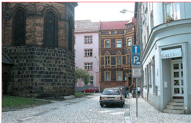
Rekonstrukce Husova nám. (u evangelického kostela, foto 2) za 1 546 401 Kč: živitý kryt vozovky a chodníků byl nahrazen dlažbou z žulových kostek, komunikace byly vyrovnány do stejné úrovně, obnoveny chodníky ke kostelu, upraveno dopravní značení.
