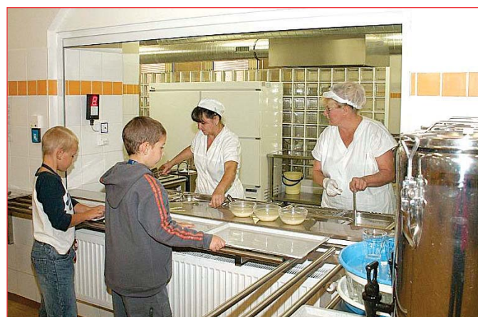
Rekonstrukce kuchyně ZŠ Nádražní na výdejnu (foto 11) za 5 454 261 Kč: zahrnovala úpravy v dispozičním řešení prostoru, obnovu rozvodů elektroinstalace, zdravotnické, vzduchotechniky aj. Výdejna má nové technologické zařízení. Obnovena je také jídelna.
