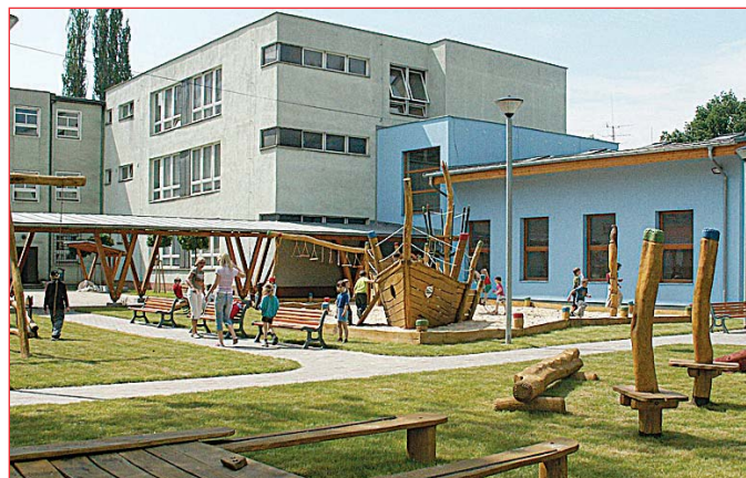
Přístavba ZŠ Zelená a výstavba dětského areálu (foto 7, 8) za 16 731 907 Kč: v nové budově ZŠ jsou umístěny družinové třídy. Přístavba s výraznou modrou fasádou je tzv. krčkem a chodbou napojena na vedlejší hlavní budovu ZŠ. Za stavbou byl zbudován dětský areál s krytou kolonádou, ping-
