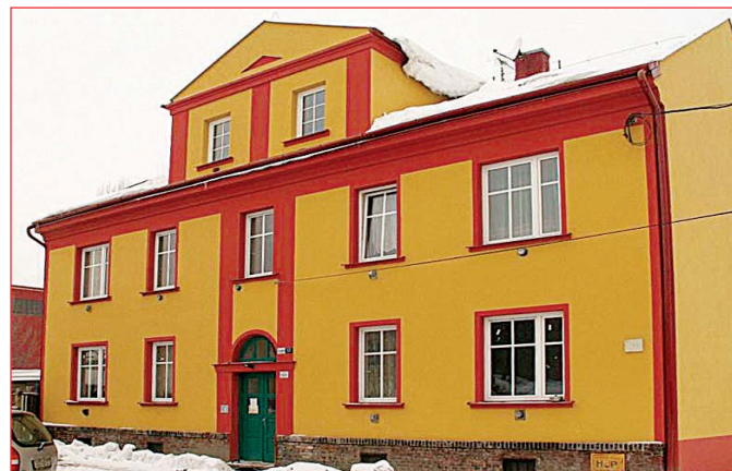
Rekonstrukce domu Válcovní 50 (foto 3) za 1 935 025 Kč: objekt s 9 bytů byl nově omítnut, byla provedena výměna dřevěných oken za plastová, v suterénu byla zabudována okna s ocelovými rámy a mimo jiné opravena střecha, elektroinstalace i dlažběni ve dvoře.
