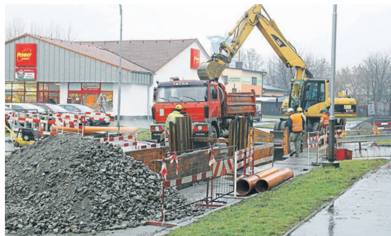
Práce na opravě vodovodu a kanalizace potrvají do začátku května.
