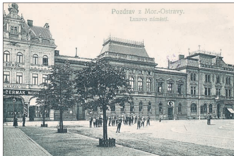
Zcela vlevo Stará sokolovna, vedle ní Národní dům, dnešní Divadlo Jiřího Myrona, před rokem 1914. Foto: fotoarchiv Ostravského muzea
