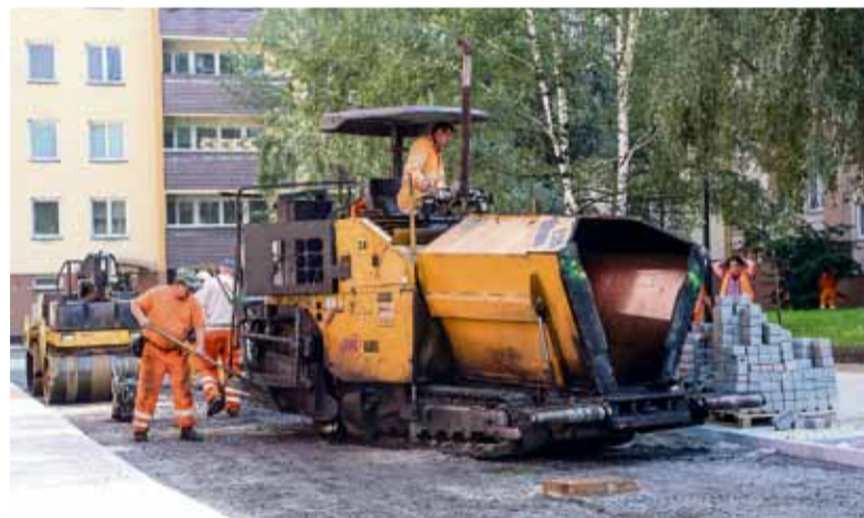
Rozbitá drolicí se asfaltová plocha v ulici Křižíkové je již minulostí.
