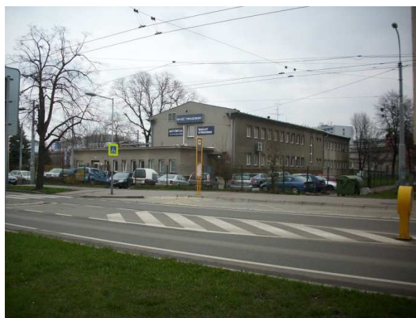
Vozovna trolejbusů na Sokolské ulici
