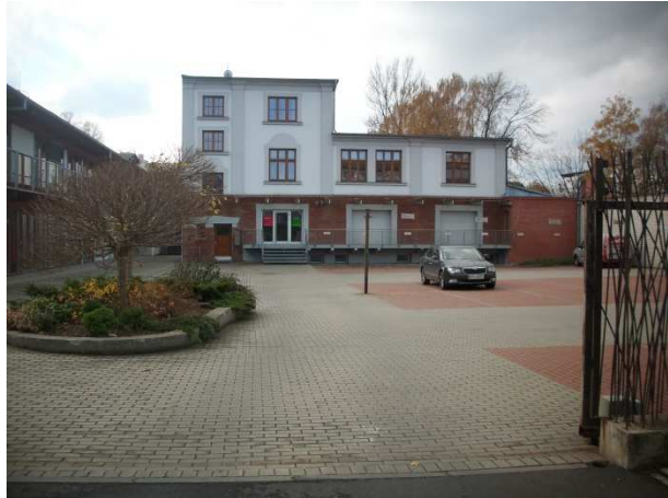
Opravený secesní dům Brandlova
